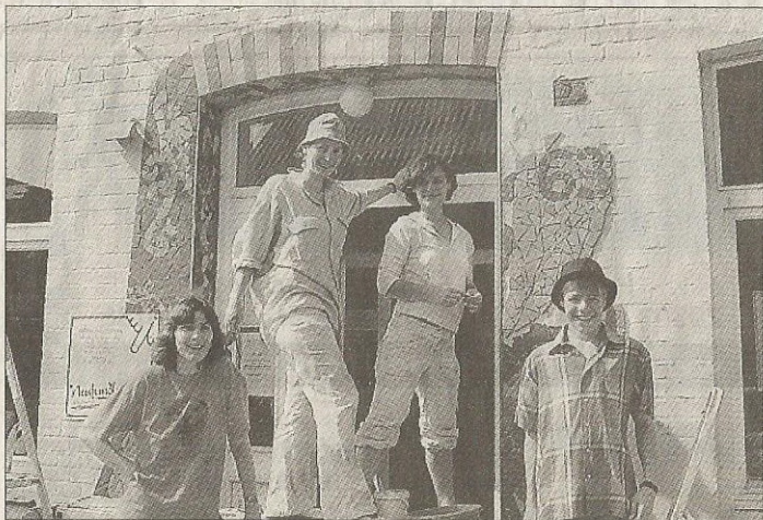
Jugendliche bei den Arbeiten am Eingangsbereich des „Neufundland“, die inzwischen abgeschlossen sind.
